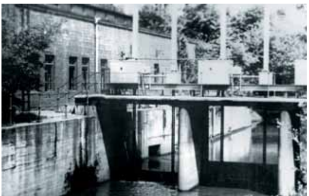
Dawne ujęcie wody chłodzącej na rzece Czarna Przemsza do kondensatorów turbin, 1963 rok. Frühere Entnahmestelle des Kühlwassers am Fluss Czarna Przemsza für Turbinenkondensatoren, Jahr 1963.
