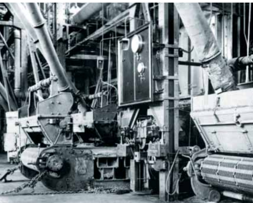
Remont kotłów niskiego ciśnienia typu Babcock-Wilcox, 1945 rok. Überholung der Niederdruckkessel, Ausführungsart Babcock-Wilcox, Jahr 1945.
