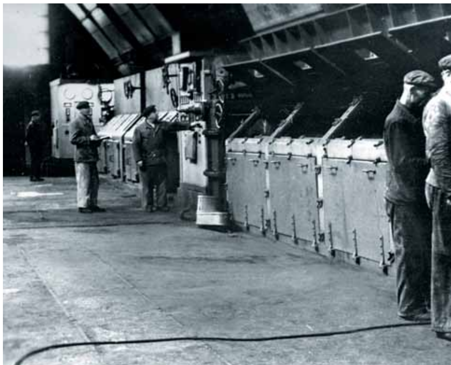
Kotłownia – kotły średniego ciśnienia, 1963 rok. Kesselhaus – Mitteldruckkessel, Jahr 1963.
