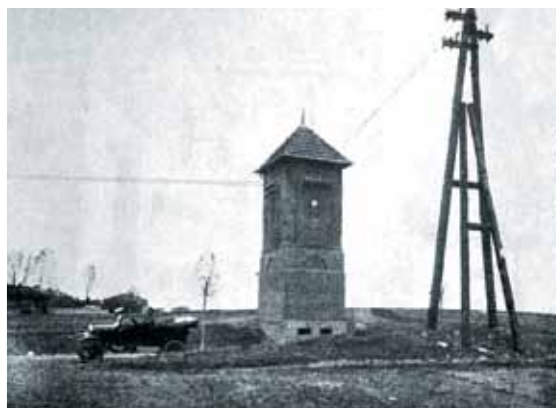
Wieża rozdzielcza, 1930 rok. Schaltturm, Jahr 1930.
